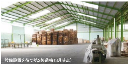
設備設置を待つ第2製造棟（3月時点）
